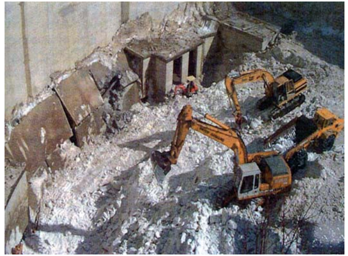
Bild 5. Aufräumarbeiten nach dem Lawinenniedergang auf die Staumauer Ferden 1999.
