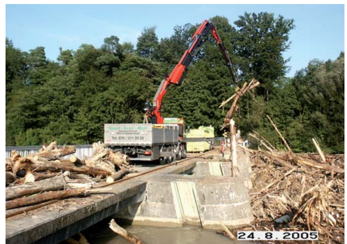
Bild 3. Aufräumarbeiten beim Kraftwerk Bremgarten-Zufikon nach dem Hochwasser vom August 2005.
